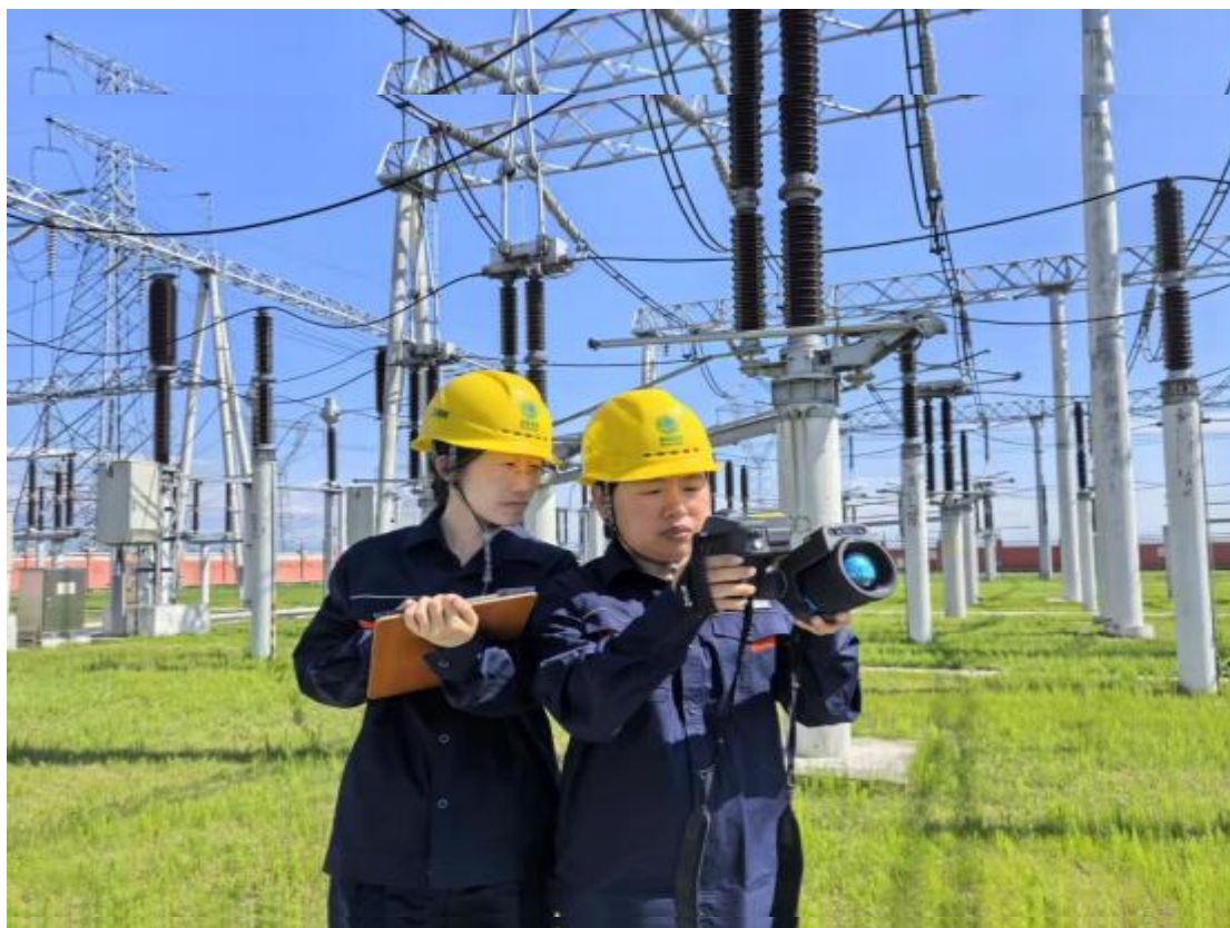
国网黑龙江超高压公司运维人员在 500 千伏哈南变电站进行高考期间设备特巡
