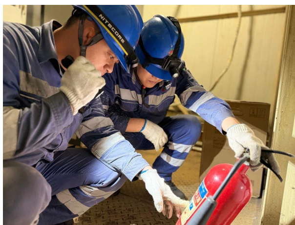
松花江热电公司员工对现场灭火器外观、压力、密封性等进行细致检查
